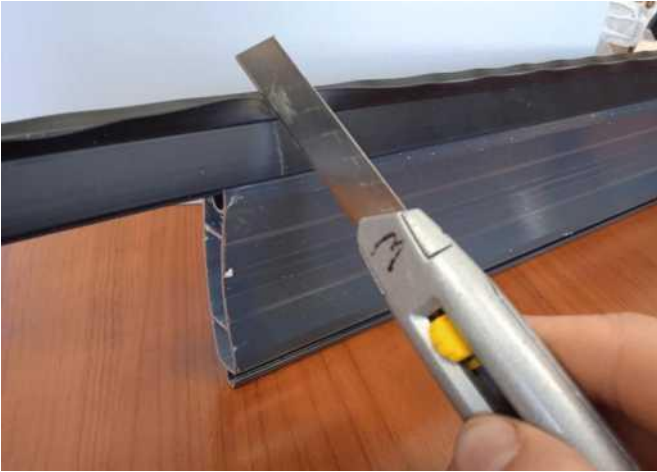
13. Schneiden Sie den Widerstandsstreifen an der zuvor markierten Stelle ab.
