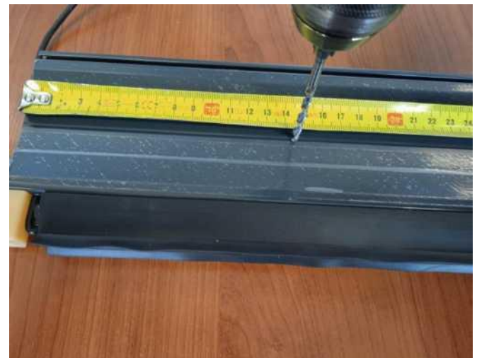
18. Auf der Seite des Widerstandssteckers mit dem Kabel bohren Sie ein Bohrloch für das Kabel. Messen Sie 14,5 cm vom Ende der Endleiste ab und bohren Sie mit einem Bohrer \varnothing 8 ein Loch in die Mitte der Leiste.
