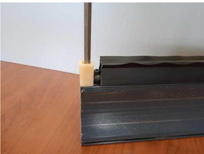
17. Schrauben Sie den Puffer mit einer Senkschraube 4x22 fest.
